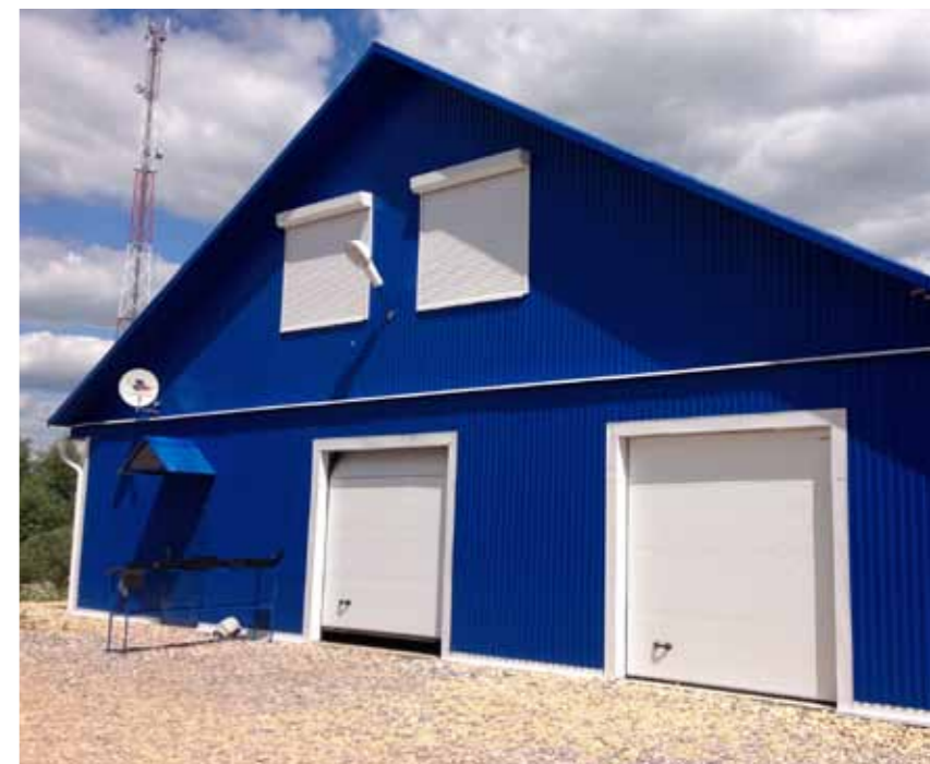
При установке ворот в помещениях с повышенной влажностью изделие комплектуется нержавеющей сталью и крепежом, обрабатываются направляющие
